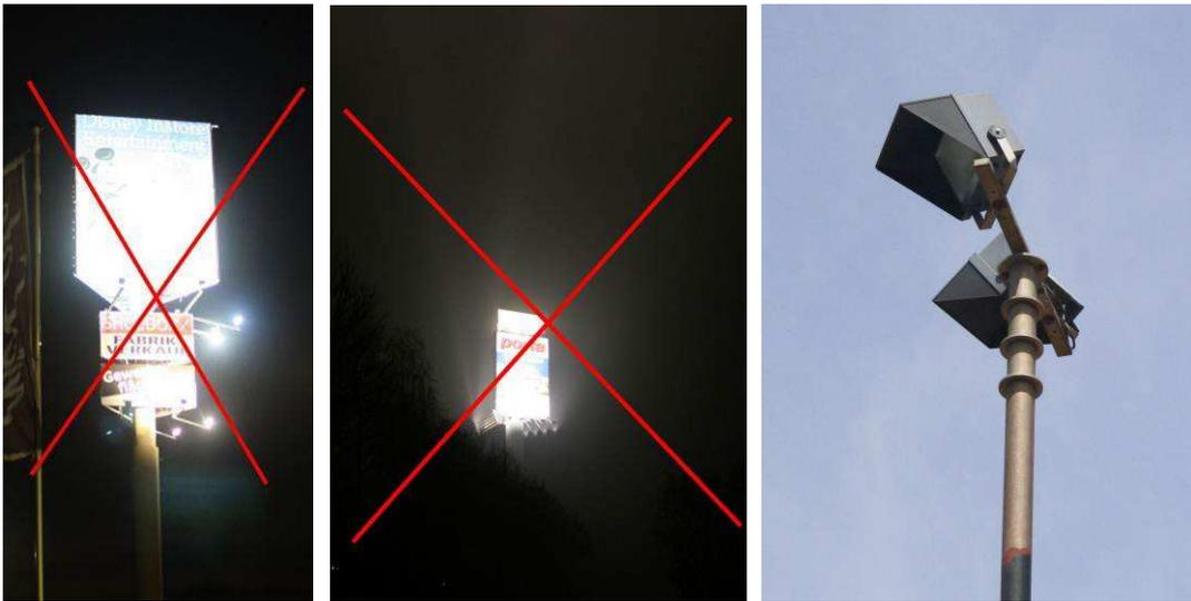
Bei Anstrahlung ist darauf zu achten, dass sie grundsätzlich nur von oben nach unten zu erfolgen hat und die Strahler so orientiert und abgeschirmt sind, dass kein Licht an der Tafel vorbei strahlt.
