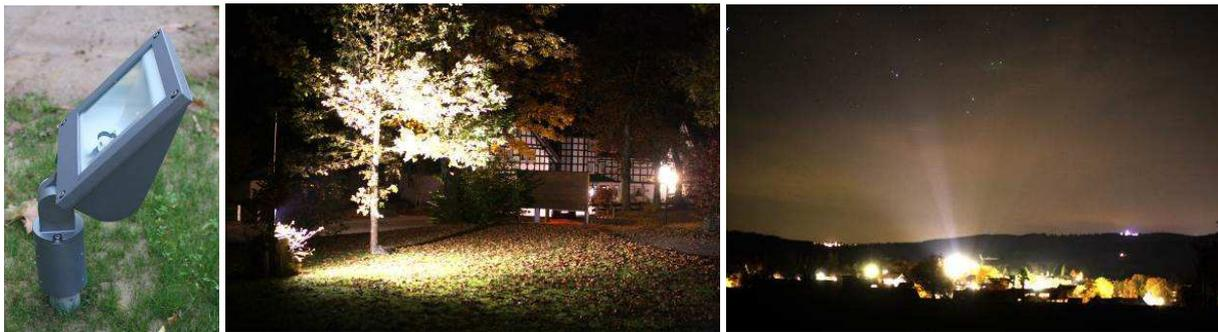
*Ein asymmetrischer Strahler kann bei exakt vertikaler Installation ein Denkmal anstrahlen, strahlt aber bei geneigter Installation (wie auf dem Bild) vor allem nach oben an den Himmel*
