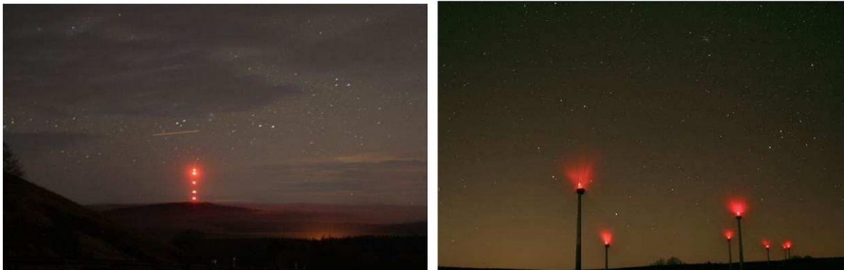
*Sicherheitsbeleuchtung bei einem Fernsehmast und Windkraftanlagen*
