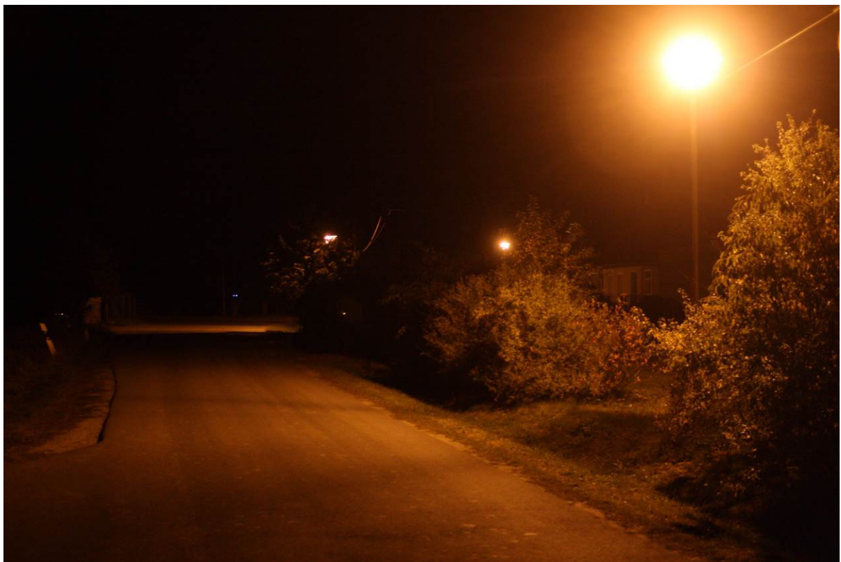
Abb. A13 und A14: Die in Witzke eingesetzten Leuchten strahlen relativviel Licht seitlich ab.
