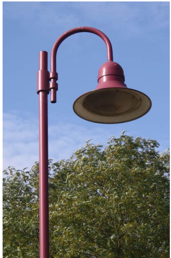
Abb. A18: Glockenleuchten mit flachem Glas (wie die rechte rote Leuchte) lenken weniger Licht zur Seite, wirken dadurch weniger blendend und sind vorzuziehen.
