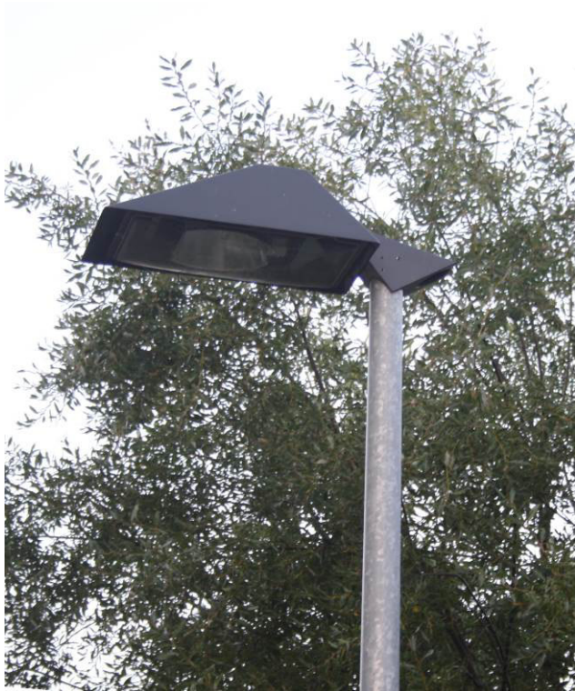
Abb. A11: Die in Lochow eingesetzten Leuchten sind voll abgeschirmt und mit Natriumdampf-Hochdrucklampen ausgerüstet.
