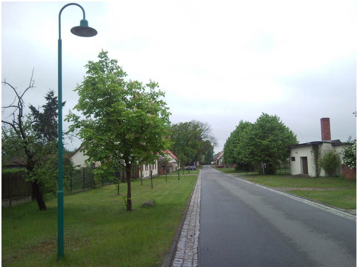
Abb. A39: Die in Parey eingesetzten Glockenleuchten sind relativ gut abgeschirmt.
