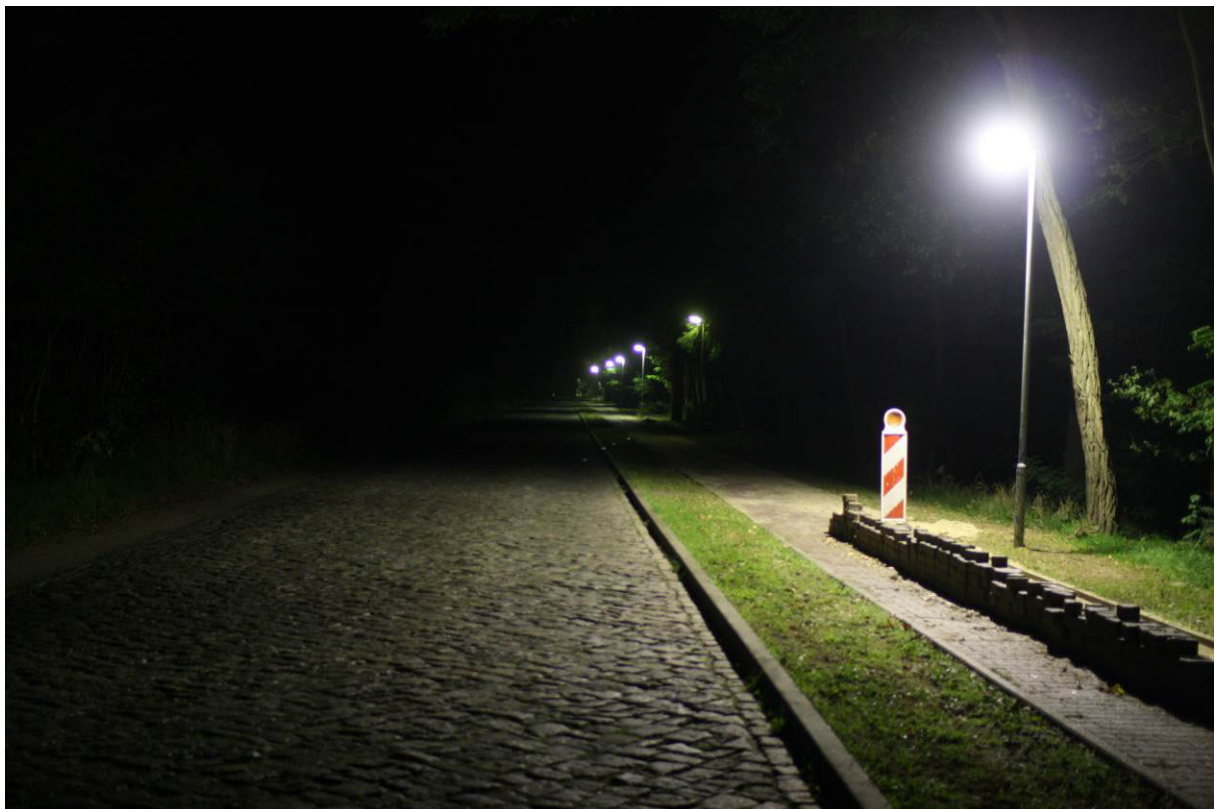
Abb. A12: In Semlin (Verbindung nach Semlin-Ausbau) werden teilweise noch Quecksilberdampflampen eingesetzt, die zudem besser abgeschirmt sein könnten.
